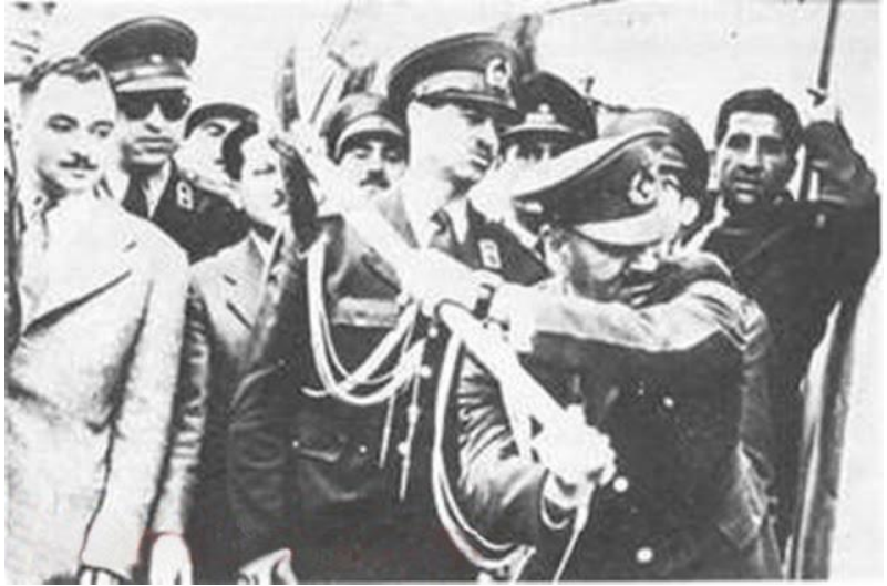
سپهبد باتمانقلیچ با کلنگ در حال تخریب حظیره القدس
